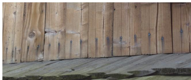
Pro upevnění prken byl použit nevhodný spojovací materiál, dřevina je v okolí spojovacího materiálu zabarvená stékající rží.
