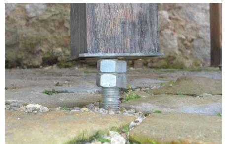
Nevhodně zvolený rozměr horní desky patky pilíře – voda se dostává do styku kovu se dřevem a výrazně tak přispívá ke zkrácení životnosti dřevěného dílu a ovlivní trvanlivost spoje. Pro upevnění horní desky patky pilíře byly také použit nevhodný spojovací materiál – vruty se zápustnou hlavou. Pro tyto spoje jsou určeny vruty RAPI-TEC® do tesařského kování.
