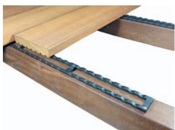
4 mm přes vylisované otvory. Terasové lišty se připevňují na osu nosníku.
