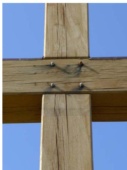
Pro spoje dřevěných dílů z dubu byl použit nevhodný spojovací materiál. Na místo nerezu A4 byl použit spojovací materiál s povrchovou úpravou galvanickým zinek. Výsledkem chemické reakce mezi výluhem ze dřeva a zinkem a železem je po krátké době červená koroze kovových dílů a začernání dřeva. Stopy stékající chemické sloučeniny po reakci krásně ukazují převládající směr větru.
