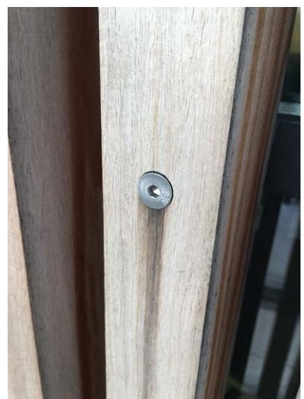
Pro dřeviny s vysokým obsahem tříslovin není vhodný ani spojovací materiál z austenitické nerezové oceli A2
